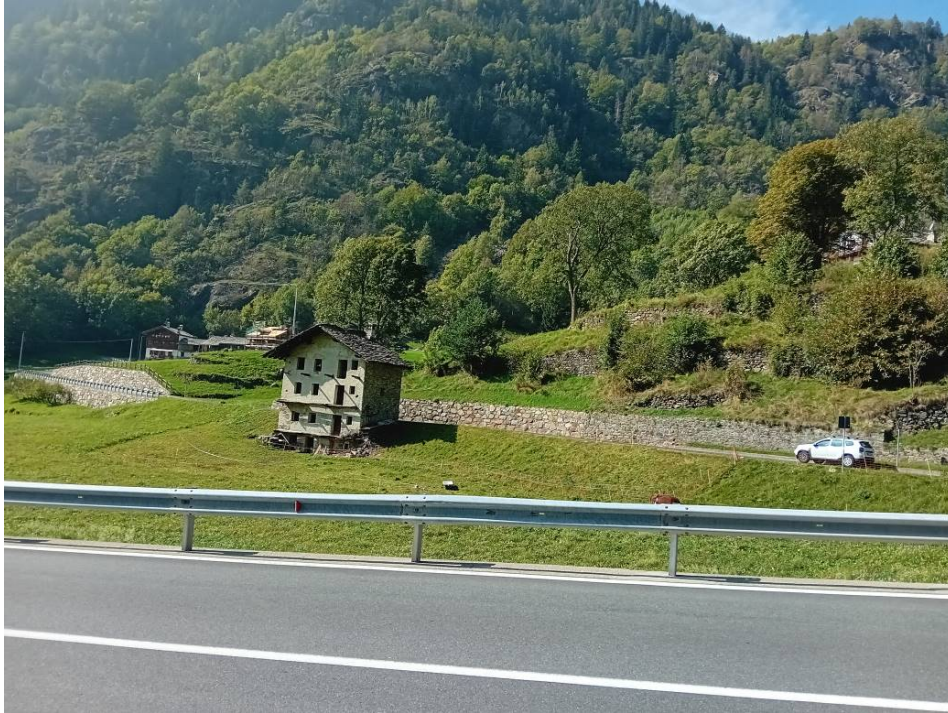
Vista da nord-est del fabbricato oggetto di interventi.
