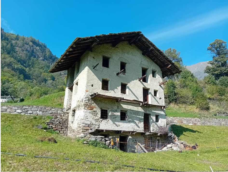
Vista da sud-est del fabbricato oggetto di interventi.
